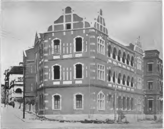
Geschäftshäuser für Europäer in Tsingtau (Kiautschou).
